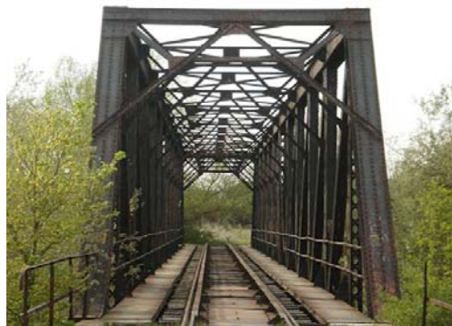
Puente de hierro
